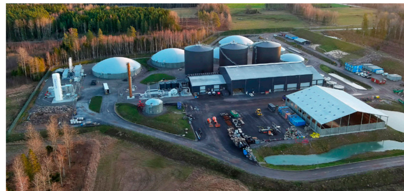
Gasums nya anläggning i Götene som kommer producera 120 GWh flytande biogas per år från främst gödsel.
